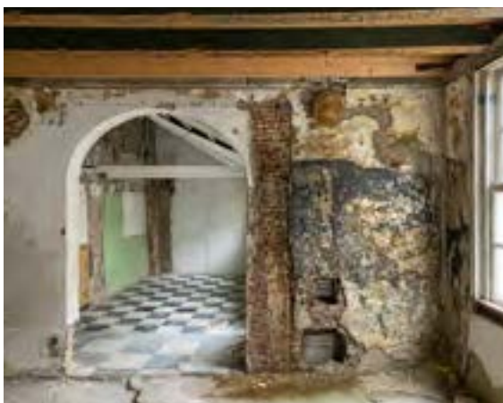
Staat Ginnekenstraat 88 voor de eerste grote renovatie foto BB Architecten
